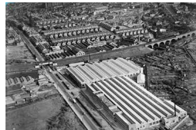
Op de voorgrond Holyhead Road met de Alvis fabrieken
